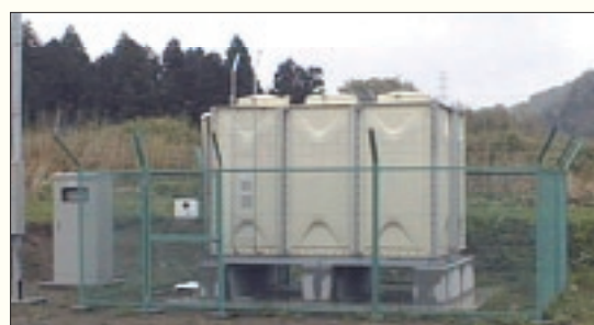
旧産業廃棄物埋め立て地に設置された地下汚染水の回収貯槽施設
